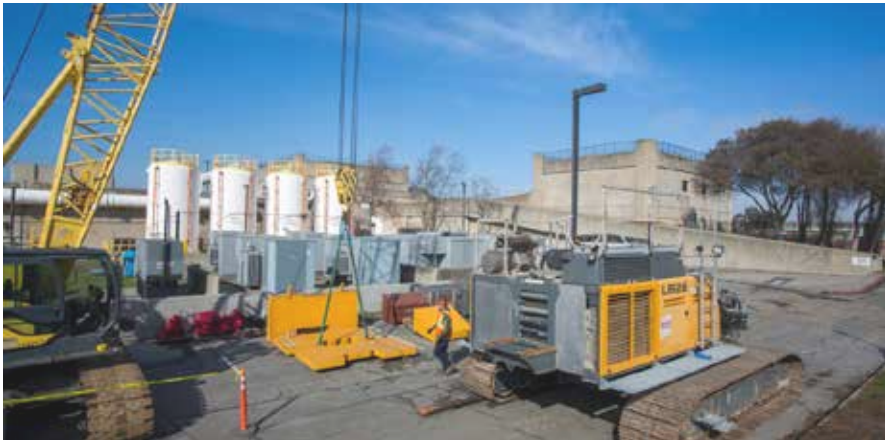
Estamos haciendo mejoras en la Planta de Tratamiento del Sudeste.
